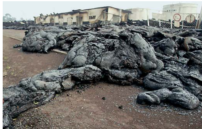
g. Coulée de lave dans la ville de Goma située à 19 km au sud du volcan (éruption de 2002). Régulièrement la lave déborde ou bien s'échappe par des fissures sur les flancs du volcan.
